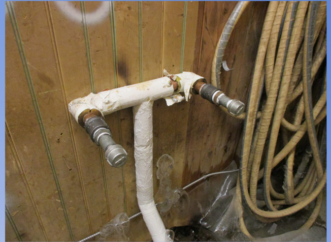
Dégelage et recapage des valves.
