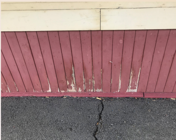
Grattage du pourtour de la Gare.
