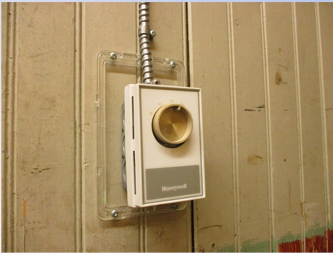
Pose d'un thermostat fonctionnel dans le local de la SCFG.
