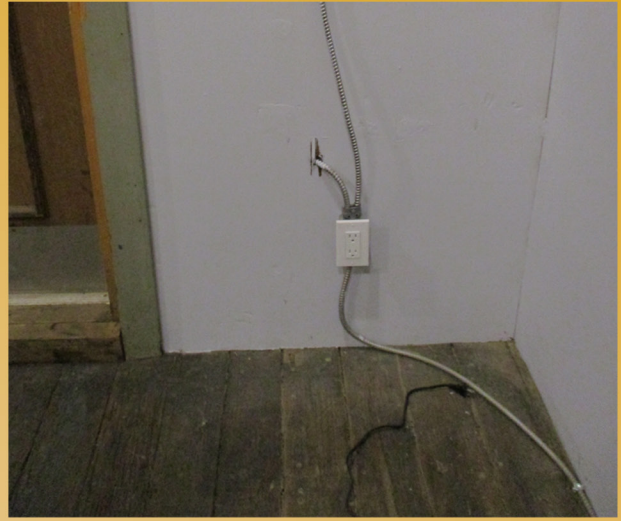
Ajout d'une prise de courant à côté de la petite porte de garage.
