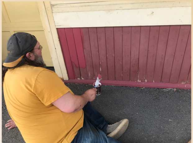
Peinture du pourtour de la Gare.
