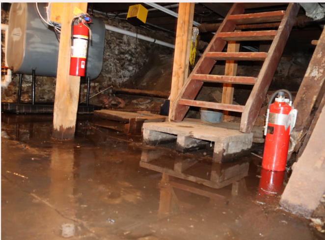
Séchage du sous-sol.
